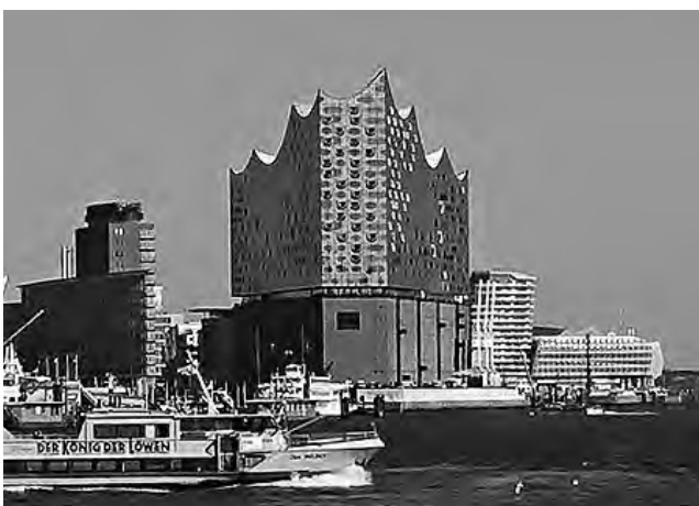
Su fisonomía como una imaginaria ola de cristal, la distingue. Su Gran Sala descansa sobre muelles para desacoplarla del edificio y contribuir con la acústica.
