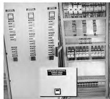
Tablero eléctrico de última generación instalado en la recuperación del Puente Dique "Punto Unido"
